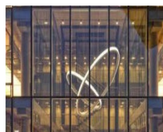
Стены – тонированное стекло, стойки и ригели RAL 7000
